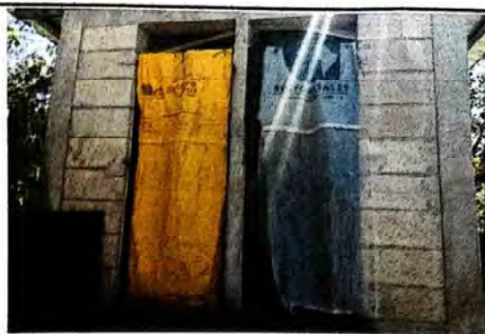
Foto 2: Reparación puerta de baños
