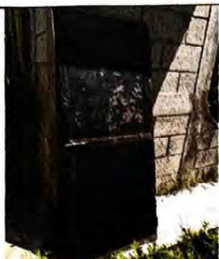
Foto 1: Reparación puerta de baños
